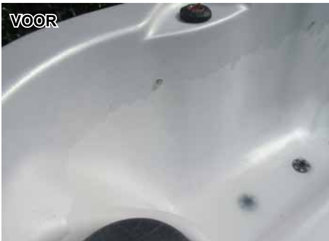
De jacuzzi vertoont enorm kalkaanslag, ook de jets zitten vol met kalk.
